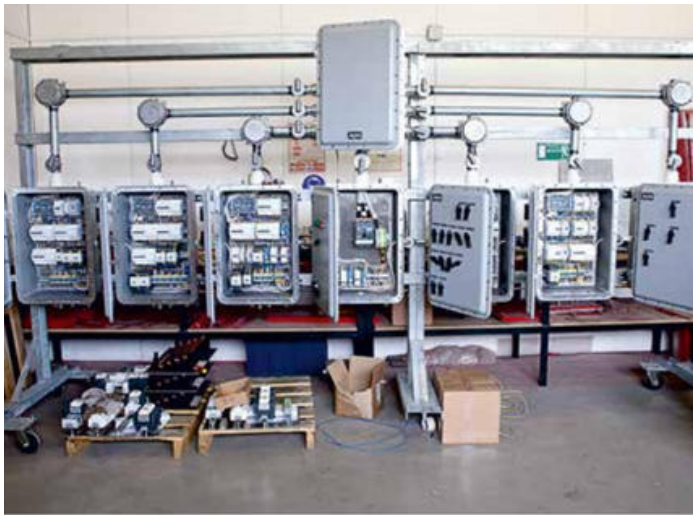
Электромонтаж между отдельными устройствами
